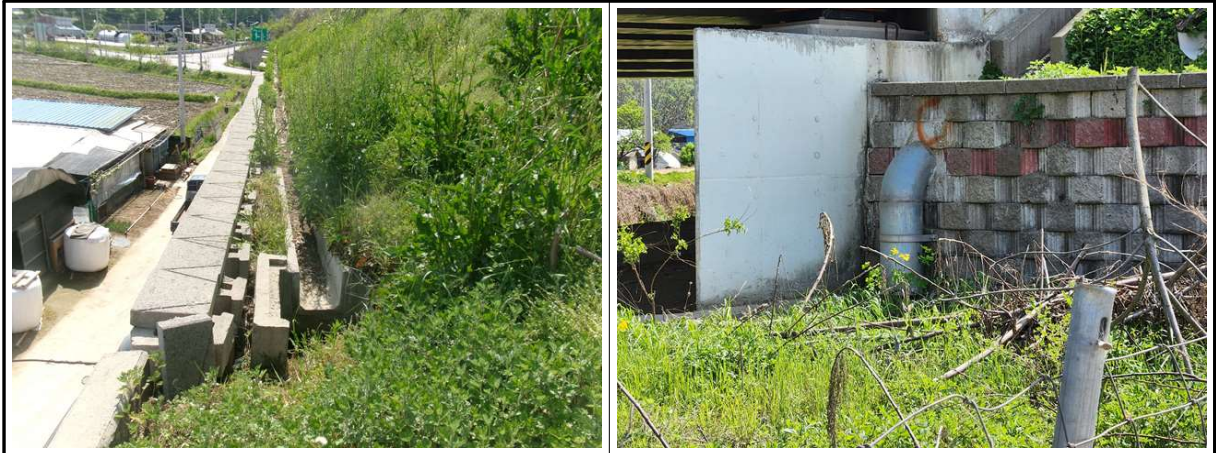
【사진 5.3.3】 배수시설 전경
