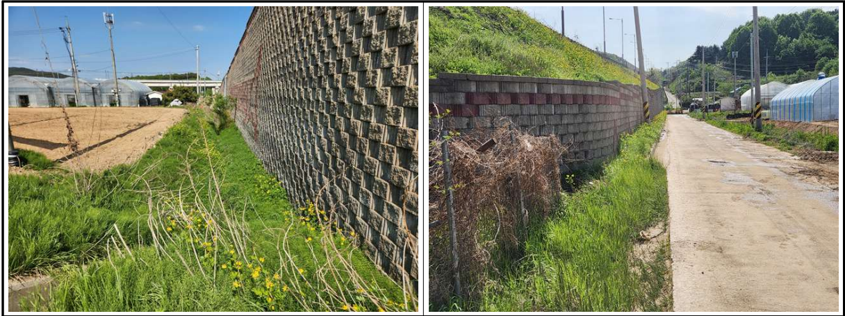
【사진 5.3.1】 지반, 기초부 전경
