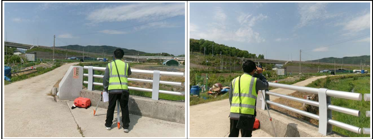
【사진 5.4.2】 측량작업 전경
