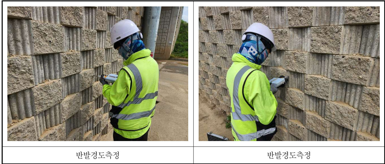
【사진 5.4.1】 재료시험 조사 전경
