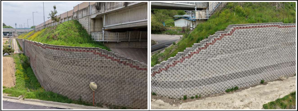
【사진 5.3.2】 전면부 전경
